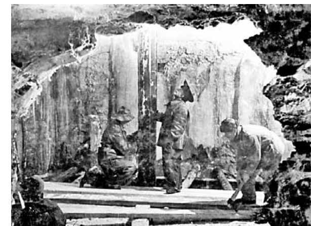
Монтаж нагнетательного трубопровода для откачки воды на главном стволе. 1945 г.
