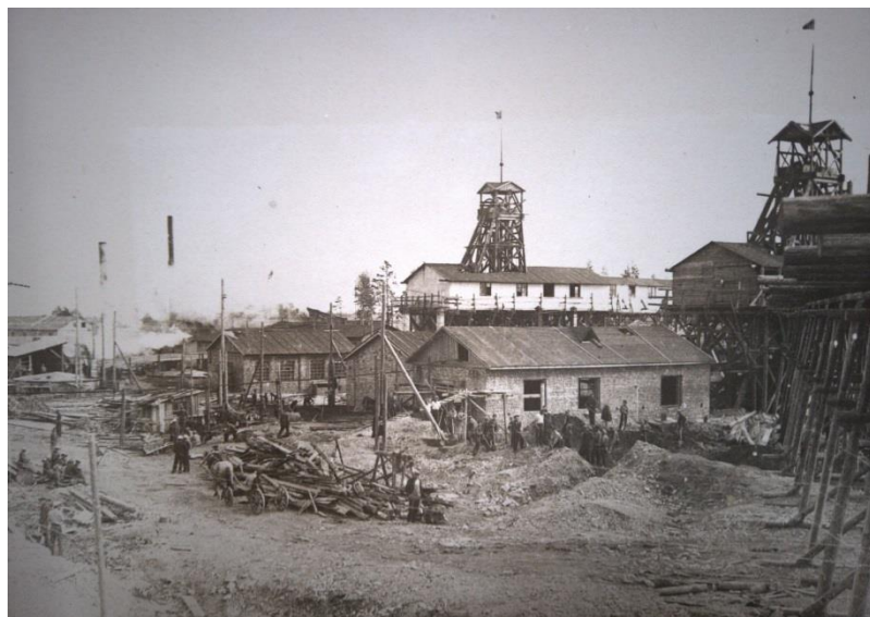
Шахта имени С.М. Кирова. Вид с эстакады на шахтный двор, копры и здания с механизмами подъёма. 1934 г.
