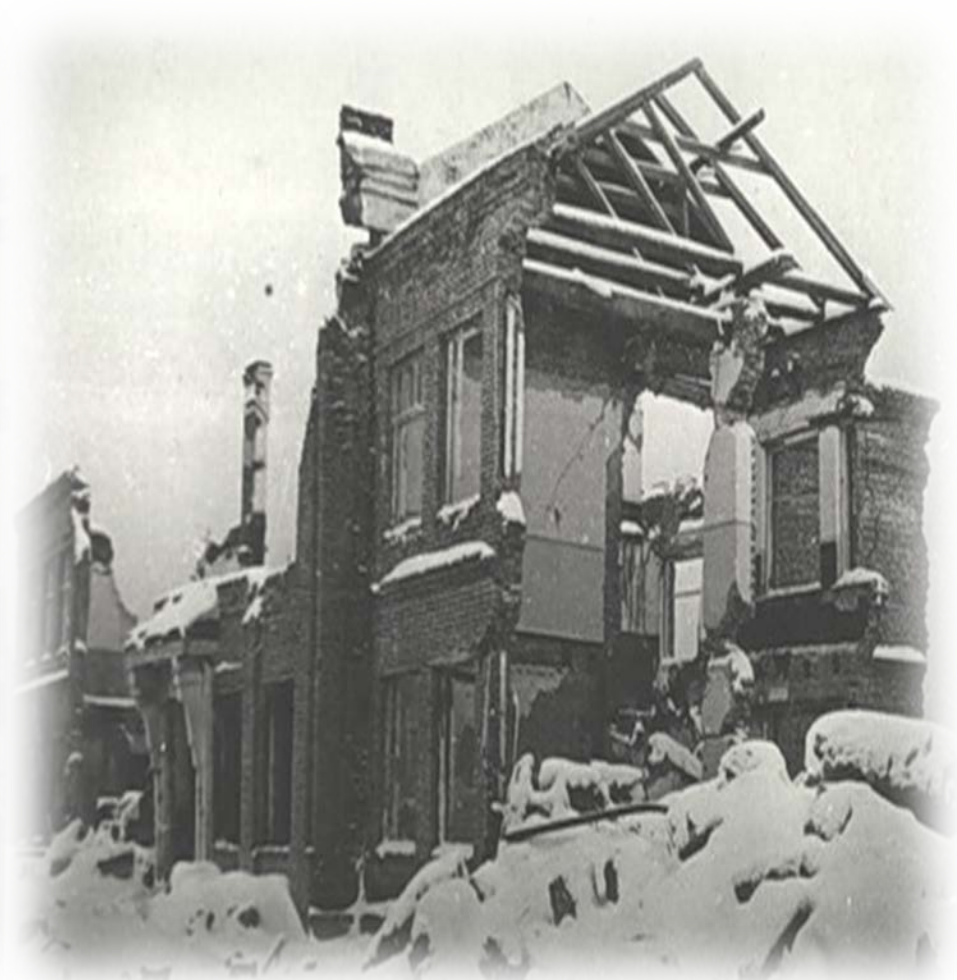
1944. Разрушенное здание школы.
