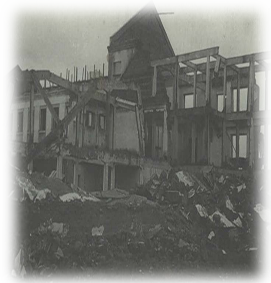
1944. Разрушенный административный комбинат шахты № 2.
