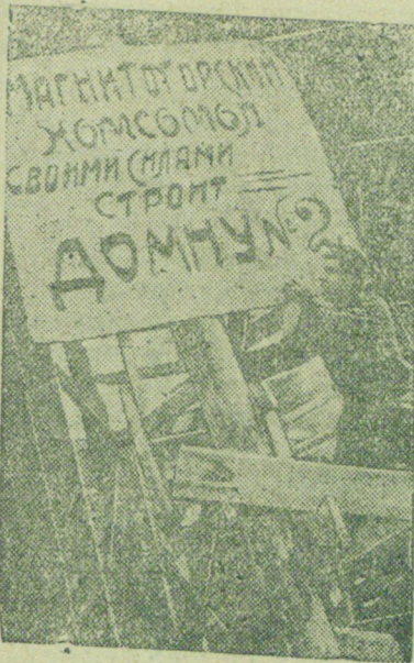
Строительство комсомольской дачи № 2 (Магнитогорск 1931 г.). Фото "Союзфото".
