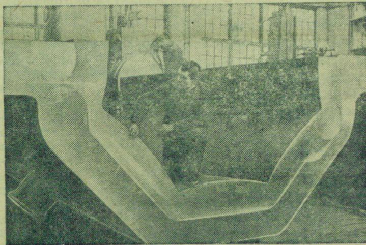
Краматорский машиностроительный завод имени Сталина получил заказ на изготовление 180-тонного коренного вала для турбины Волгостроя.
