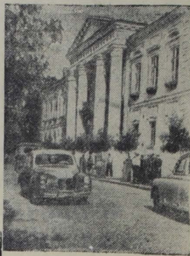
Белорусская ССР. Здание исполкома Гродненского областного Совета депутатов трудящихся на улице Ожешко в г. Гродно. Фото В. Токарева.
