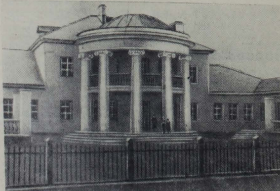
Быстро расширяется сеть детских учреждений в нашем районе. Коллектив строительного управления № 4 треста «Ленинградстек» построил большое красивое здание детских яслей, в котором разместятся около 50 детей рабочих и служащих. Здание принято комиссией госстройконтроля. Работа строителей получила хорошую оценку.
