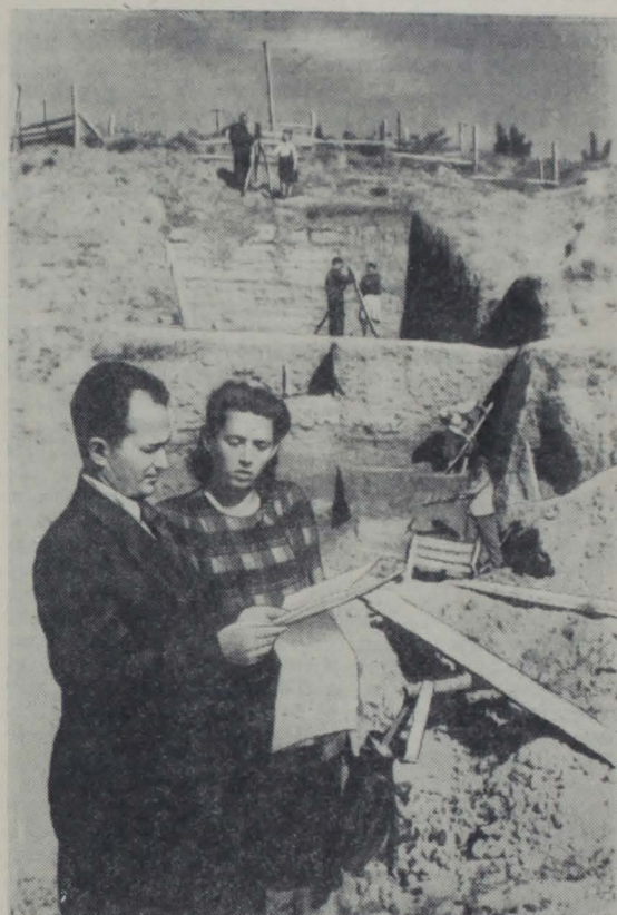
Сталинград. На месте предстоящей стройки Сталинградской гидроэлектростанции развернулись изыскательские работы. На снимке: проходка опытной шахты на правом берегу Волги в районе, где будет сооружена плотина. На переднем плане заместитель главного геолога Н. П. Сивяков и старший техник-геолог комсомолка Е. Н. Страхова. Фотохроника ТАСС.
