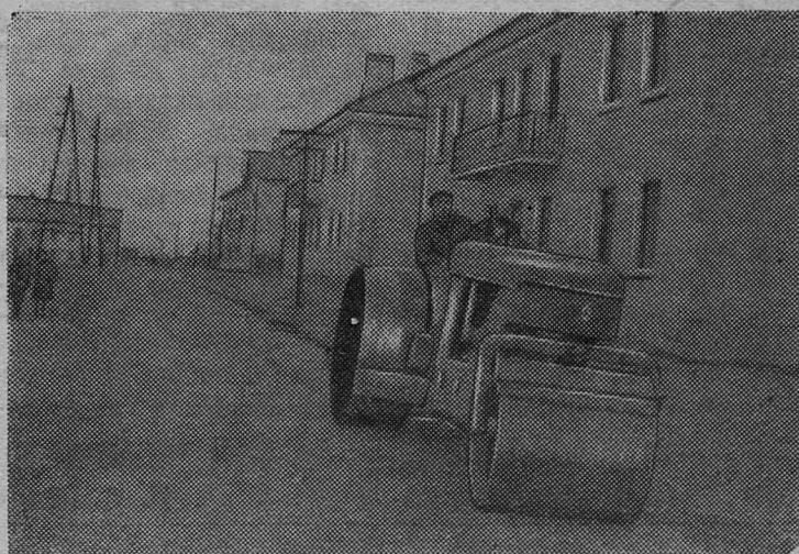
Сланцы. Работы по благоустройству Спортивной улицы. Фото П. Вересова.
