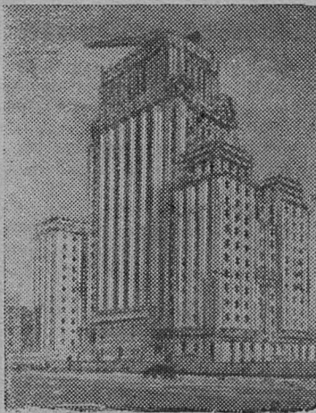
Москва. Строительство высотного административного здания на Смоленской площади. Фото Н. Грановского.
