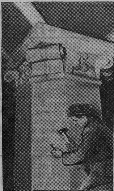
Строительство 4-й очереди Московского метрополитена. Мраморщик А. Захаров за отделкой колонны на станции «Комсомольская». Фото Л. Великжанина.
