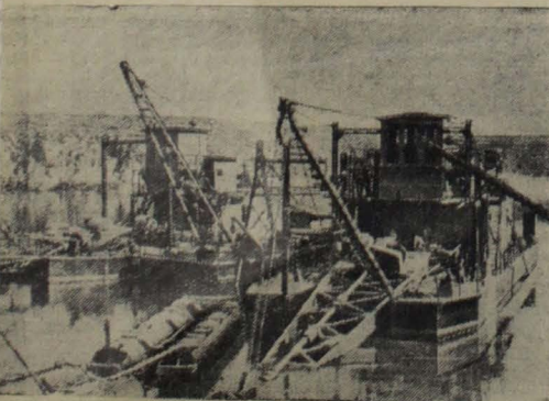
Запорожье. Бригада Шербаковского завода довершила закончить монтаж и спустила на воду второй земснаряд, предназначенный для строительства Каховской ГЭС. На снимке: земснаряды перед отправкой в Каховку. Фото А. Красовского. Пресскляше ТАСС
