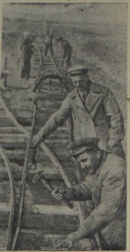
Краснодарский край. В колхозе «Память Ильича» Марьяновского района строят механизированный кирпично-черепичный завод. На снимке: сооружение узкоколейной дороги к заводу.
