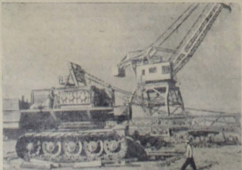
Ташта-Таш. На монтажных вагонах строителя Ташта-Ташского гидроузла идет сборка семикубового электрического экскаватора, предназначенных для рытья котлованов. На снимке: сборка семикубового электрического экскаватора. Фото О. Кузмина. Прессгазета ТАСС
