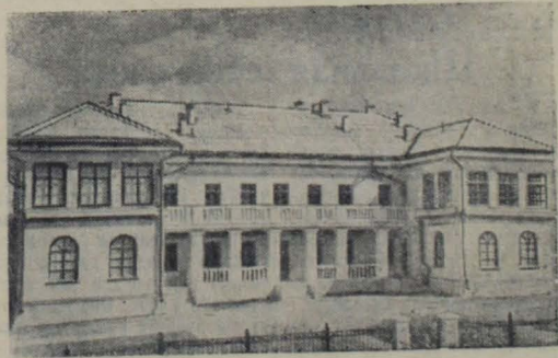
Челябинск. В Металлургическом районе города закончено строительство здания детских яслей, рассчитанных на 120 детей. На снимке: новое здание детских яслей. Фото В. Георгиева. Прессклише ТАСС
