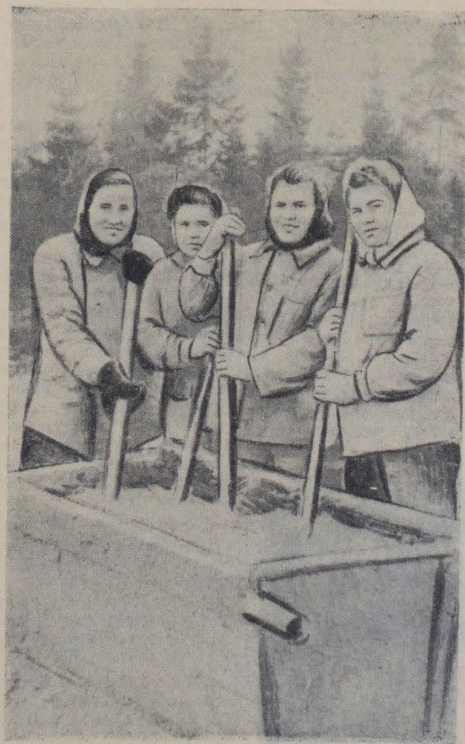
По-стахановски трудятся на строительстве теплофикационной сети нашего молодого города изолировщицы треста «Ленинградгазстрой». Каждая из них ежедневно выполняет нормы выработки на 150 процентов.
