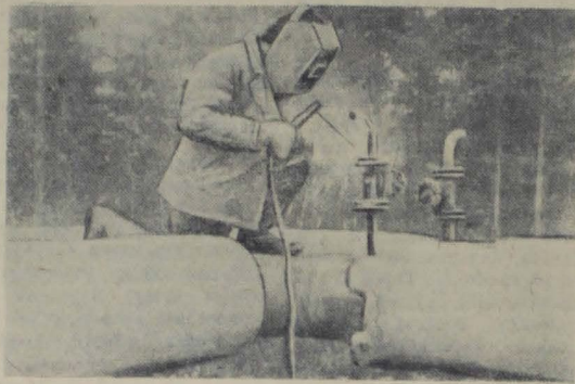
Гор. Сланцы. На прокладке теплофикационной сети Рудничная - поселок Большие Луки.
