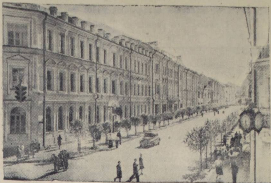
Неузнаваемо изменился Смоленск в послевоенные годы. На жилищное строительство отпускаются большие средства. Создан ряд новых улиц.
