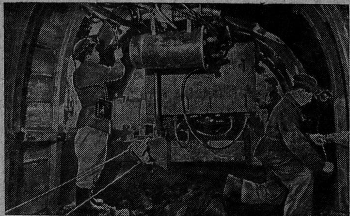
Приморский край. Горняки Приморья успешно осваивают технику, поступающую на шахты. Высоких показателей в работе добились проходчики шахты 3-ц треста «Артемуголь», получившие недавно горнопроходческий комбайн «ШВМ-1». Применение этой машины ускорило проходание выработок более чем в три раза и увеличило втрое производительность труда. Значительно возрос также заработок горняков.
