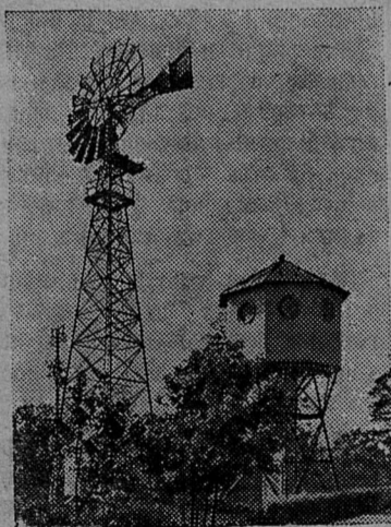
Москва. Всесоюзная сельскохозяйственная выставка. Ветро-насосная станция с ветродвигателем «ТВ-8».
