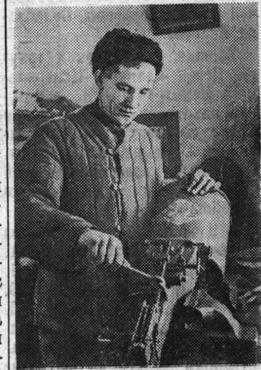
Крымская область. Много ценных рационализаторских предложений внес за время своей работы в Красноармейской МТС механик коммунист П. И. Трещев. Недавно он сконструировал и изготовил высевающий аппарат к сеялке «СКГ-6». Вместо обычного клапана П. И. Трещев поставил металлическую задвижку оригинальной конструкции на каждый сошник сеялки.
