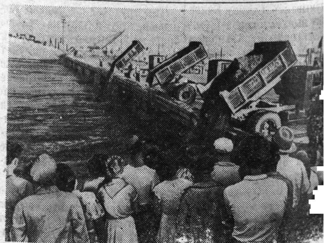
Иркутск. На площадке у подножия островков плотинной ГЭС выстроились автосамосвалы, бульдозеры, автокраны. Семь часов вечера по местному времени 8 июля началась заливка бетона. К наплавному мосту с правого и левого берегов один за другим устремляются пятитонные самосвалы. Они обрушивают бетон в реку. В воды Ангары сыплются тяжелые камни, бетонные гравий.
