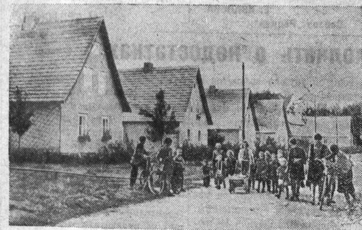
На снимке: одна из улиц Фрейлебена. Фото Центральбидд.
