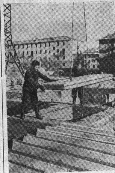
КАРАГАНДИНСКАЯ ОБЛАСТЬ. На строительных участках города Балхаша все более широкое применение находит сборный железобетон.
