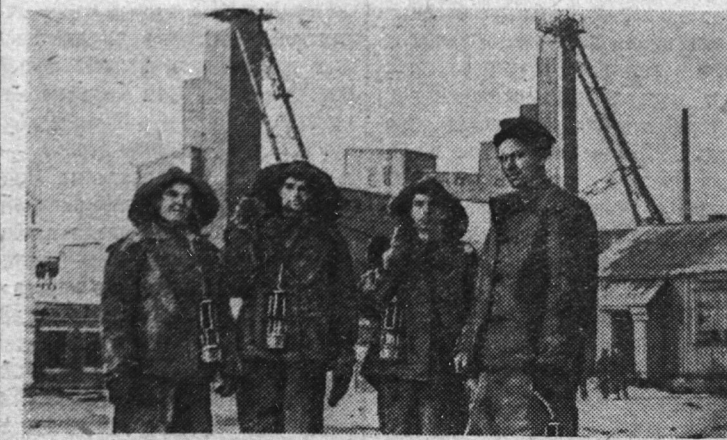
На снимке: лучшие шахтостроители Козельской шахты № 2. Слева направо — бригадир Н. К. Дианов, проходчики В. В. Карев и А. М. Дюков. Фотохроника ТАСС
