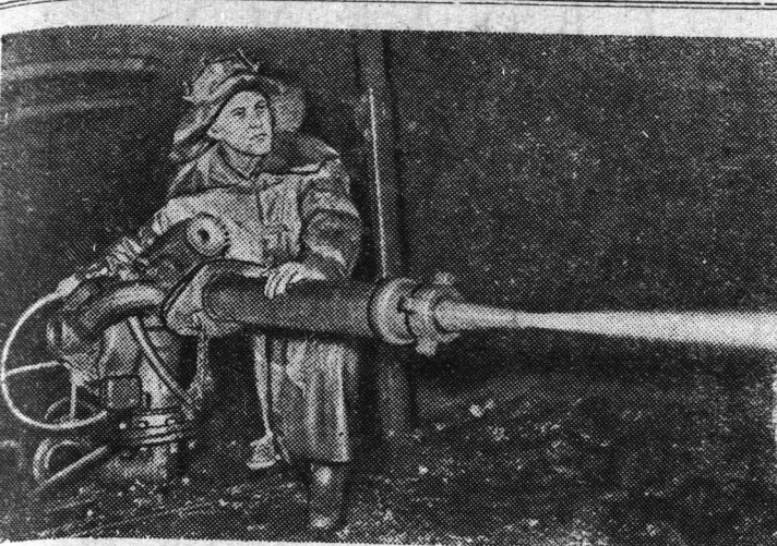
Кемеровская область. На угольных шахтах Кузбасса находит применение новый так называемый гидравлический способ добычи угля. Уголь из забоя водой подается в насосную, а оттуда на-гора на обогатительную фабрику. Отпадает необходимость в вагонетках, электровазгах, в большом штате обслуживающего персонала. Сейчас уже построена и действует гидрошахта «Польсаевская—Северная».
