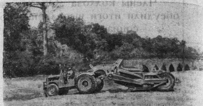
Камбоджа. Строительство оросительной системы в провинции Сиен-Реап. Фото Н. Генералова.
