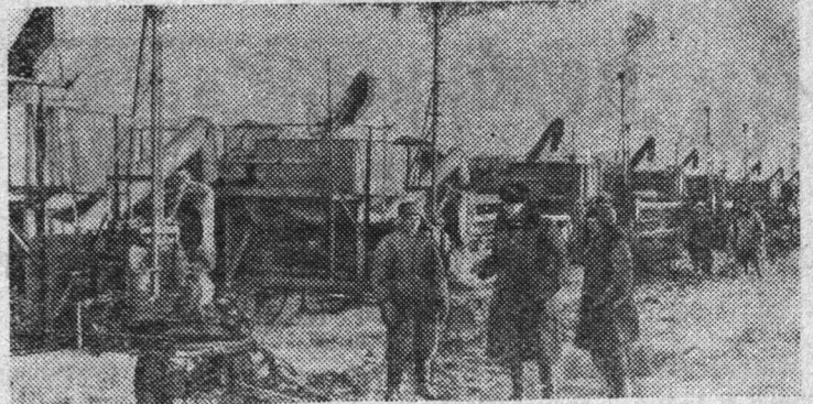
Казахская ССР. В МТС имени Пушкина Северо-Казахстанской области развернулось социалистическое соревнование за окончание к 1 января ремонта всей сельскохозяйственной техники. Механизаторы добились на ремонте больших успехов. Они уже отремонтировали 40 комбайнов при годовом плане 47.
