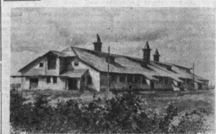
Коровник на 200 коров, построенный с применением сбор- ных железобетонных конструкций в колхозе «Искра» Всево- ложского района Ленинградской области. Фото ЛенТАСС
