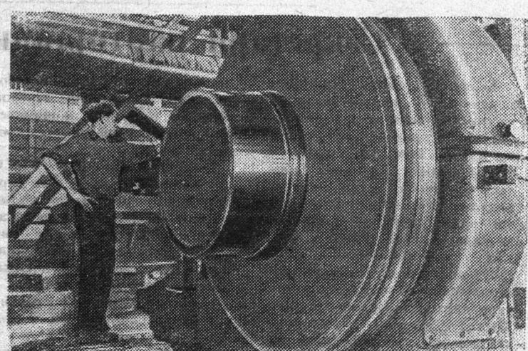
Куйбышевская область. На Сызранском заводе тяжелого машиностроения освоен способ получения высокопрочного чугуна. Внедрение этого способа позволило заводу заменить стальные отливки, снизить себестоимость продукции более чем в два раза, не изменяя прочности изделий.
