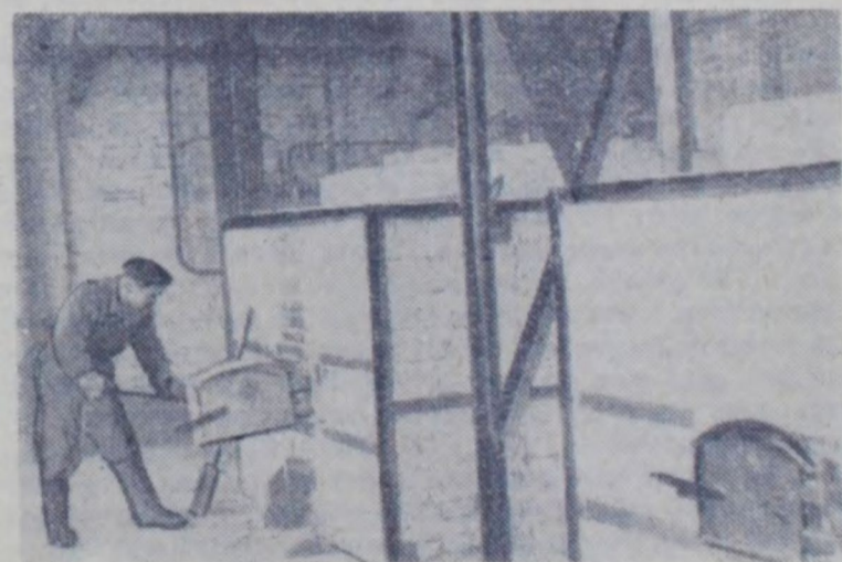
Котельная райпищекомбината. На снимке: кочегар И. Блажев за шуровой топкой.
