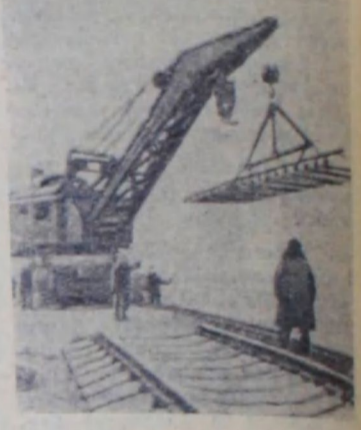
Китайская Народная Республика. На сооружении 1.100-километровой трассы железной дороги Баотоу—Ланчжоу для экономии лесоматериалов используются железобетонные шпалы. Движение поездов будет открыто к концу нынешнего года.
