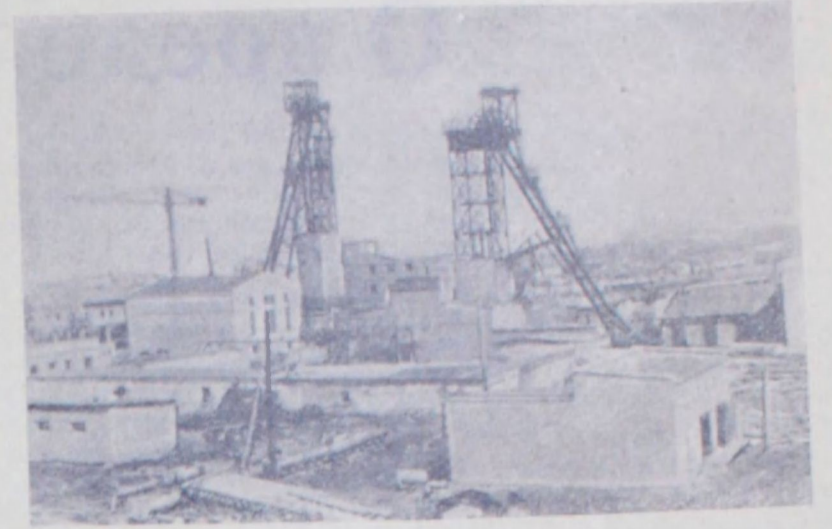
Кемеровская область. В городе Ленинске-Кузнецком сооружается шахта «Егзовская» № 1. Коллектив треста «Лениншахтстрой» решил ко Дню шахтера сдать в эксплуатацию четыре лавы.
