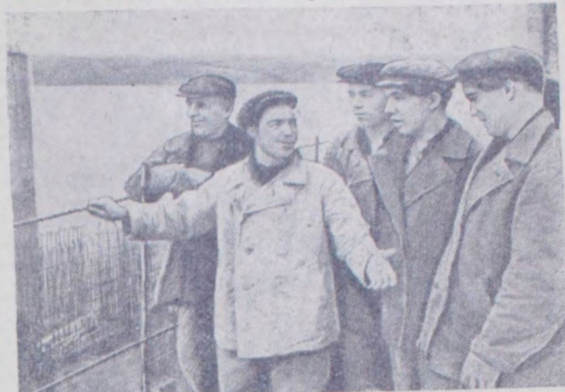
Оренбургская область. На реке Урал создается новое водохранилище для бесперебойного снабжения водой Орско-Халиловского металлургического комбината. Близ поселка Ирикля сооружается плотина с гидроэлектростанцией мощностью 15 тысяч киловатт. Коллектив строительного управления «Ириклстрой» Оренбургского совнархоза взял обязательство досрочно, в сентябре этого года, ввести в строй 4 гидроагрегата из 6 запроектированных. Уже проделаны большие работы. Строители вынули 300 тысяч кубометров мягких грунтов и полтора миллиона кубометров скального. В тело плотины вложено 210 тысяч кубометров бетона. На снимке: передовая бригада бетонщиков. Слева направо — Авдей Ильин, бригадир Алексей Сенин, Сергей Миловидов, Николай и Юрий Ганевы. Укладывают бетон в левобережные устои плотины ГЭС, они выполняют по две нормы в смену. Фото Б. Клипиницера. Фотохроника ТАСС.
