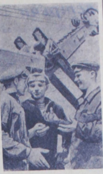
Украинская ССР. Расширяется фронт работ в новом Днепровском угольном бассейне. Кроме двух действующих разрезов — Байдаковского и Семеновско-Головковского треста «Александрияуголь», здесь намечено строительство еще нескольких крупных разрезов.
