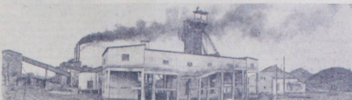
На снимке: панорама наземных производственных сооружений шахты имени С. М. Кирова.
