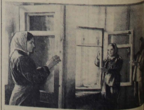
На снимке: члены бригады маляров Бабаджанова (управление № 7) шпаклюют оконные переплеты.
