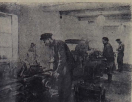
В сельхозартели имени XX партсъезда Кингисеппского района построена колхозная механическая мастерская. Здесь установлены токарные, фрезерный и сверлильные станки. Все необходимые ремонтные работы в колхозе проводят работники этой мастерской. На снимке: внутренний вид колхозной мастерской. На переднем плане — токарь В. В. Алев. ЛенТАСС
