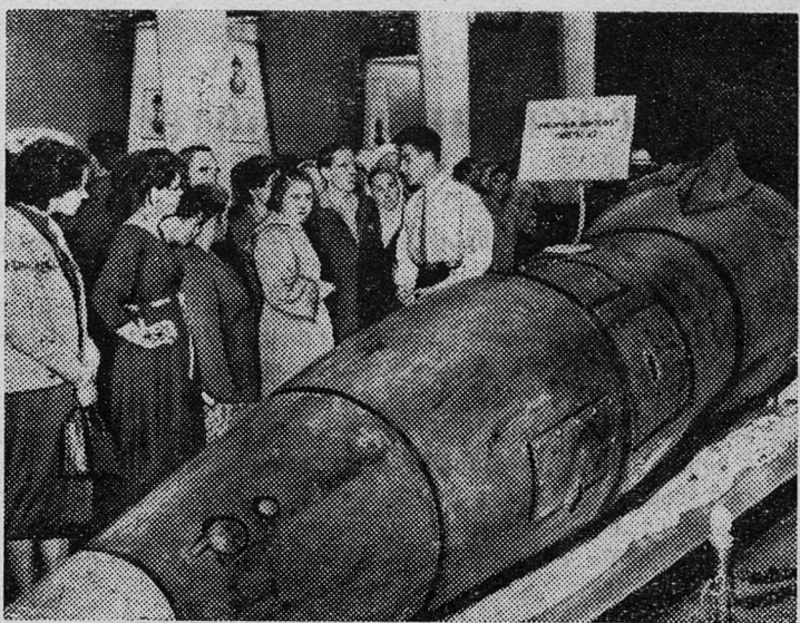
Выставка достижений народного хозяйства СССР. В павильоне Академии наук. Посетители осматривают приборный контейнер ракеты «А-3», побывавшей на высоте 452 километра.
