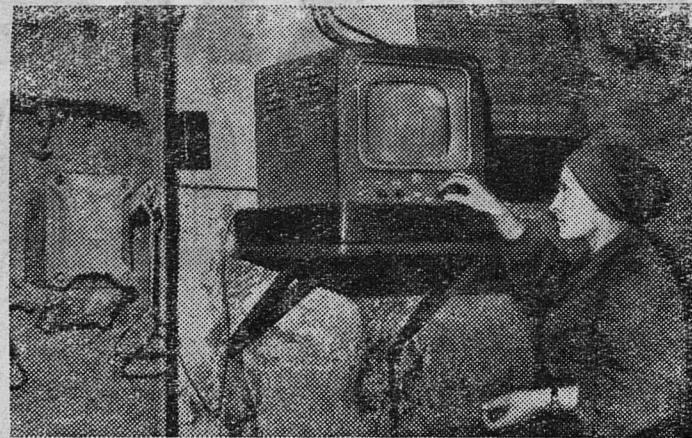
Сталинская область. На шахте № 13 треста «Куйбышевуголь» оборудованы две промышленные телевизионные установки — у клетьевого ствола и у горного диспетчера. Телевизионные камеры дают возможность наблюдать за действием механизированного породопрокладывателя и за подъемом на клетьевом стволе. Управление ими таким образом — облегчается.
