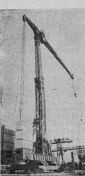
**КАЛИНИНСКАЯ ОБЛАСТЬ.** На Ржевском механическом заводе началось серийное производство шагающих башенных кранов «КТС-5-10». Новый мощный кран предназначен для использования на крупнопанельном строительстве восьмистенных зданий. Он сможет поднимать груз в десять тонн на высоту 11 метров, а пятитонный груз — на высоту 22 метра. Обслуживать кран будет один человек.
