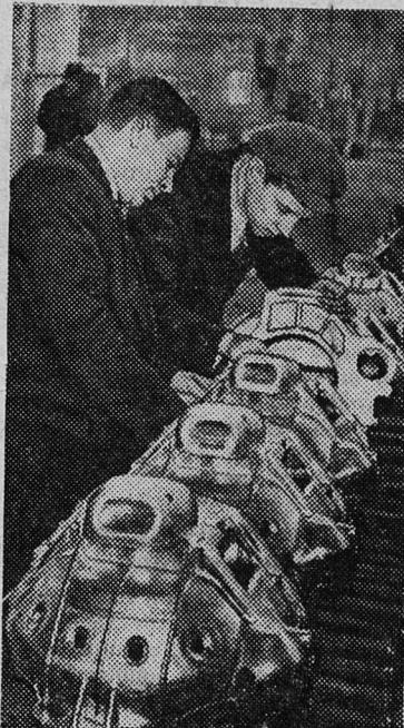
Горьковская область. Строительство крупного Заволжского моторного завода вступило в завершающую фазу. Готовится к пуску первая очередь предприятия. На участке литья блоков и картеров моторов автомашины «Волга» варятся первые тонны алюминиевого сплава, из механических кокильев извлекаются первые отлитые детали.
