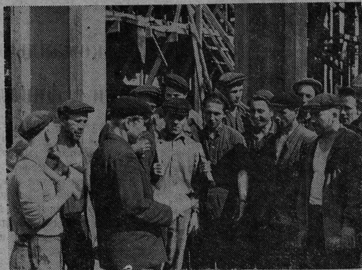
Хорошо потрудились в минувшем месяце плотники бригады Василия Ивановича Иванова. Своё обязательство по устройству опалубки они выполнили на 104, а нормы выработки — на 169 процентов.
