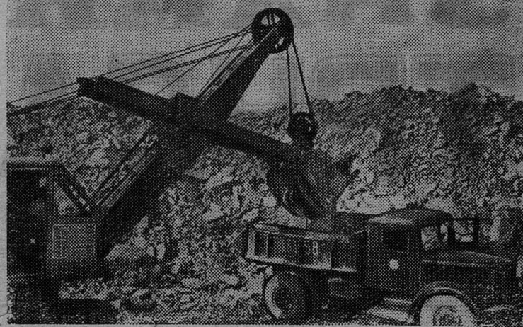
ЛЕНИНГРАДСКАЯ ОБЛАСТЬ. 100 лет добывают ценный строительный материал — бутовую плиту на Колчановских разработках Войбокальского карьероуправления. Сейчас карьер переживает вторую молодость, он снабжен новейшими механизмами. НА СНИМКЕ: погрузка бутовой плиты. Фотохроника ЛенТАСС
