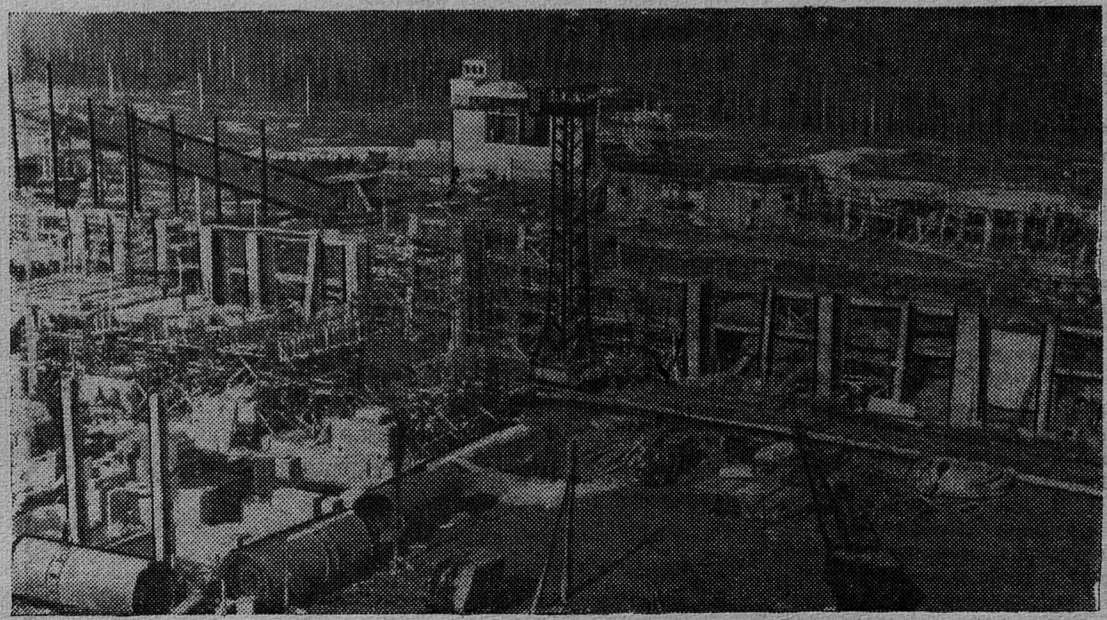
НА СНИМКЕ: панорама строительства Сланцевского цементного завода.
