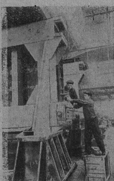
Коллектив Ижорского завода работает над созданием комплекта оборудования для изготовления крупных железобетонных деталей, идущих на строительство жилых зданий. В комплект входят семь станков, на которых изготавливаются стенные железобетонные панели, панели с оконными и дверными проемами, междуетажные перекрытия, лестничные марши и площадки.
