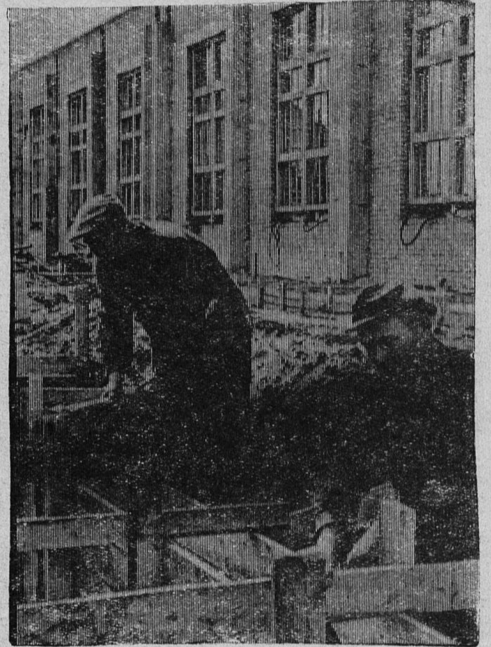
На снимках: (вверху) передовые каменщики комплексной бригады И. Ф. Потапова ведут кладку внутренних стен здания; (внизу) плотники Н. В. Майоров и Н. Г. Григорьев делают опалубку внутренней канализации завода.
