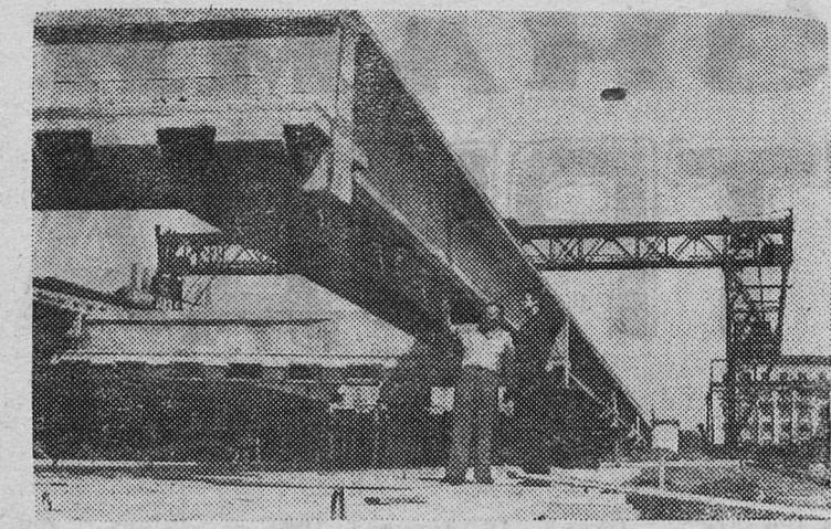
Идет опалубка для сооружения железобетонного пролета.
