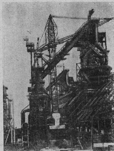
На строительстве Карагандинского металлургического завода поднялась вторая Казахстанская дамба. С большим подъемом работают ее строители. Бригада монтажников Александра Пищеникова на высоте около семидесяти метров установила последнюю звено наклонного газопровода дамской печи.
