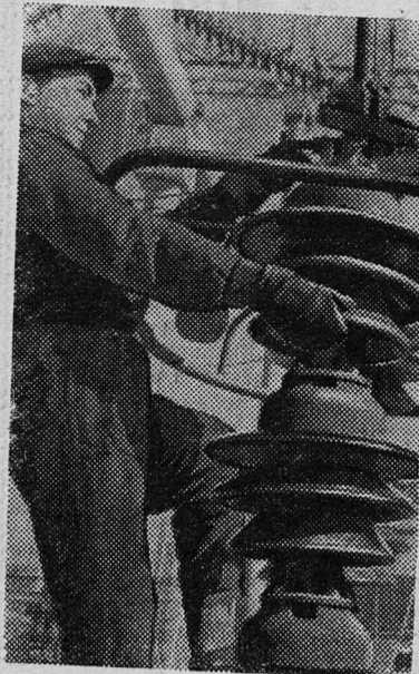
НА СНИМКЕ: монтажник А. Ф. Козочкин регулирует разведительное устройство на 220 киловольт.
